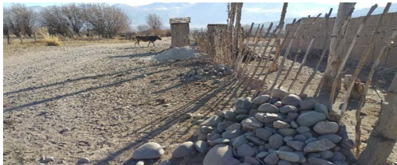
Фото 4. Расширение земельного участка – строительство уборной/туалета на муниципальной дороге/улице
